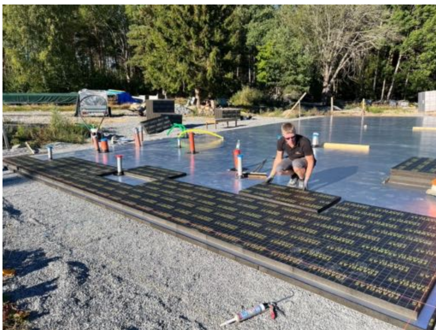
Fig 4.1: montering av andra lagret av FOAMGLAS® FLOORBOARD isolering "B" mm från byggnadens färdiga utsida.
